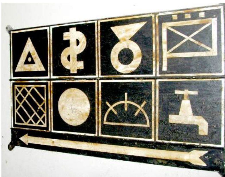
Da sinistra a destra e dall'alto in basso: Osservatorio; Posto di medicazione; Riserva di munizioni; Comando dell'opera; Camerata dell'opera; Posto radio; Caponiera per difesa vicina e Riserva d'acqua.
