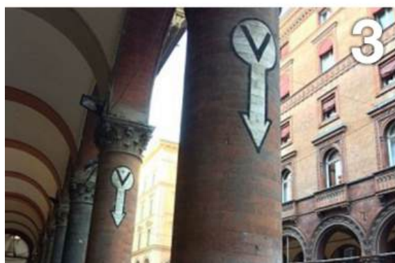
1) Lettera F accreditata per Fontana; 2) Lettera S per Serbatoio idrico; 3) Lettere V per pozzi di ventilazione; 4) Sigla US (Uscita di Sicurezza) con la specifica "in corte" e freccia biancorossa..
