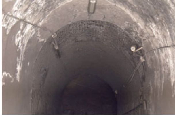
Veduta interna della galleria che collegava via degli Annibaldi alla metro B Cavour
