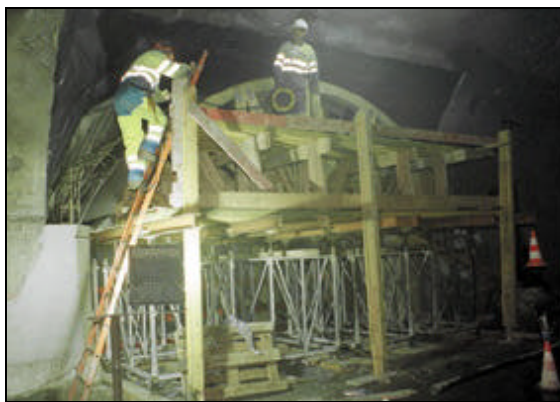
I lavori di risistemazione del tunnel del Monte Bianco che riaprirà a dicembre.
