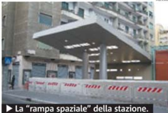
► La “rampa spaziale” della stazione.
