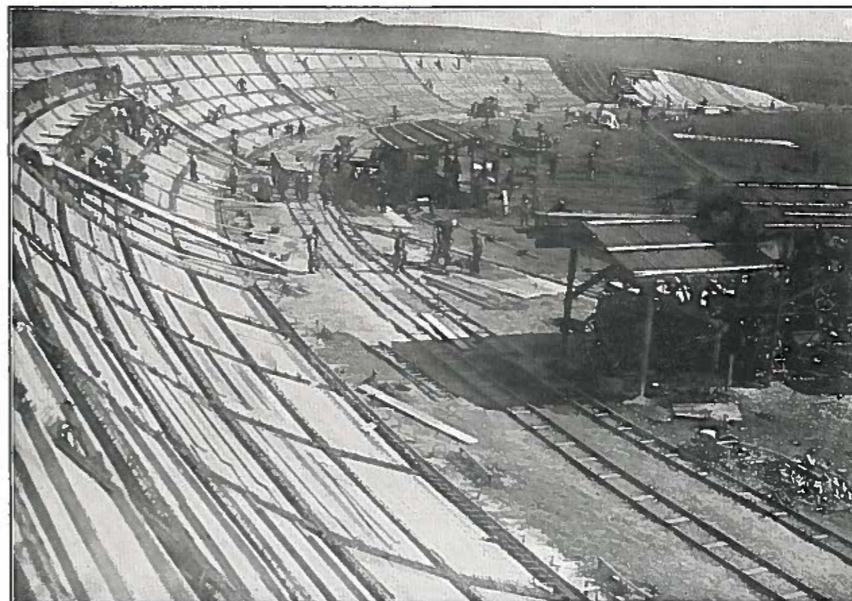
Fig. 3. — Il getto del calcestruzzo.
