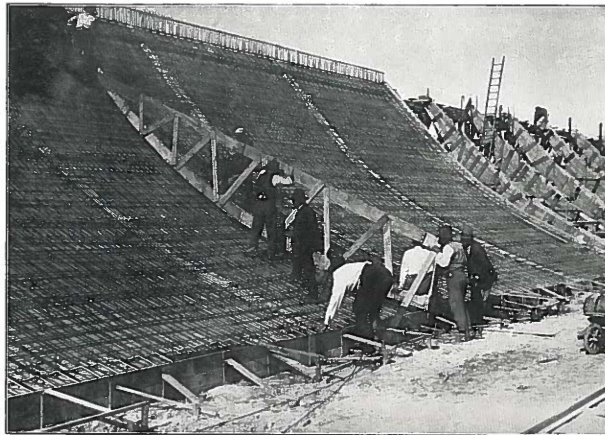
Fig. 2. — L'armatura per la curva.
