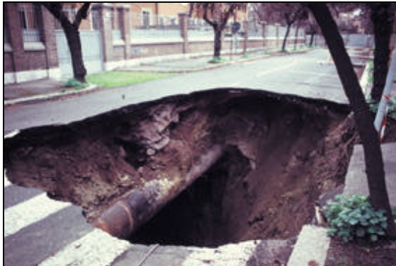
Voragine stradale provocata da una perdita d'acqua al quartiere Aventino.
